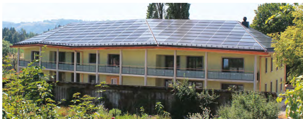
Das neue Odilienhaus aufgenommen im Herbst 2023. Die Arbeiten für den Innenausbau sind noch in vollem Gange.
